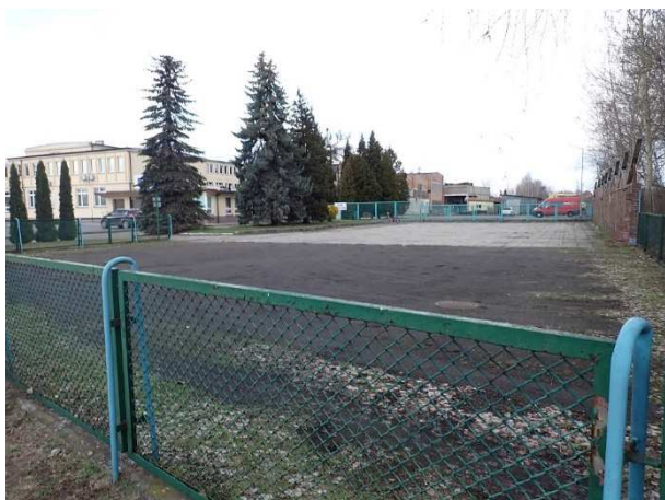
Fot. 8. Widok na zabudowę fabryki wentylatorów Fawent.
